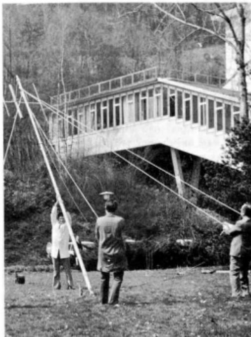
Abb. 6-4 Aufrichten des Antennenmastes
