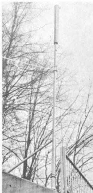
Abb.4-9 Sperrtopfantenne, montiert
